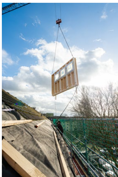
Bochum-Mitte: Ein seriell gefertigtes Energiesprung-Element schwebt auf die Baustelle.
